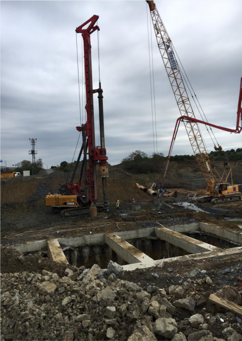
HASDAL KAVŞAĞI K.BURGAZ- YASSIÖREN DEVLET YOLU
