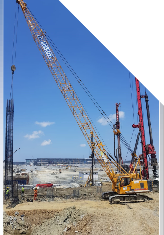
HASDAL KAVŞAĞI K.BURGAZ- YASSIÖREN DEVLET YOLU
