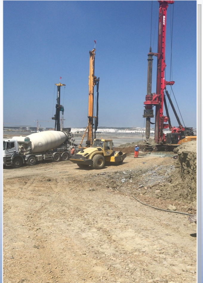
HASDAL KAVŞAĞI KEMERBURGAZ DEVLET YOLU
