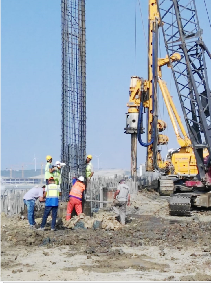
HASDAL KAVŞAĞI K.BURGAZ- YASSIÖREN DEVLET YOLU
