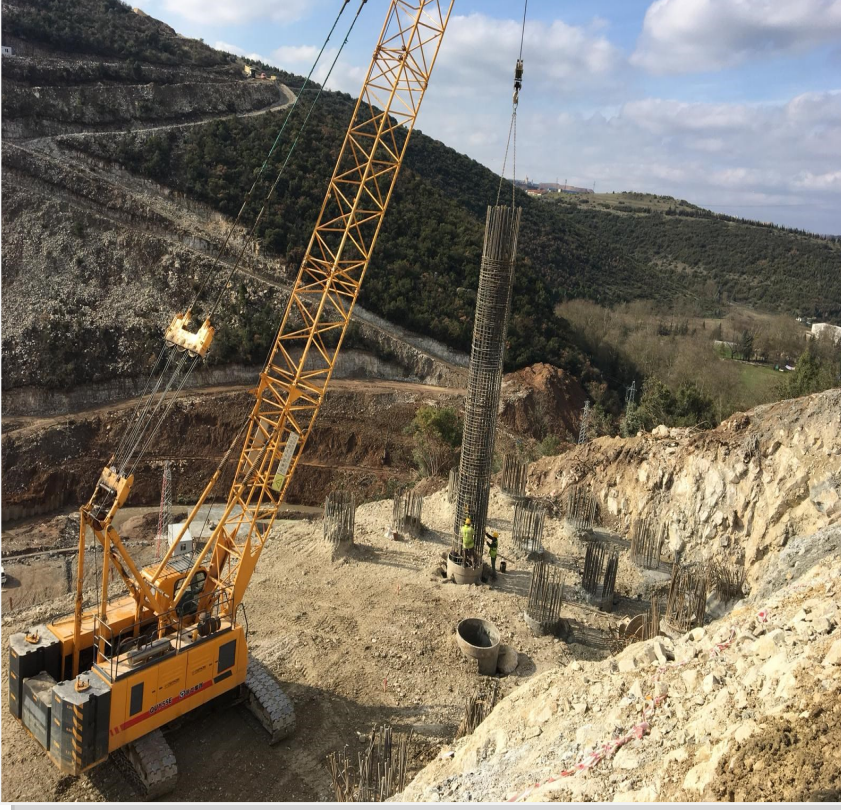
KUZEY MARMARA OTOYOLU DİLOVASI
