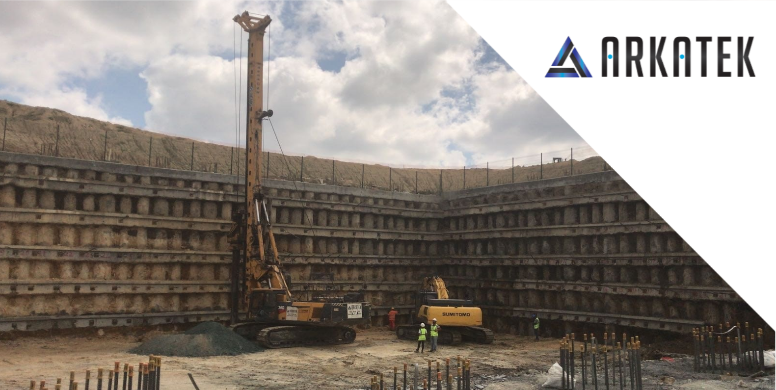
İ.V.V. ТВЕРДЫЕ ОТХОДЫ И ЕНЕРЖИ ПРОИЗВОДСТВЕННЫЕ МОЩНОСТИ
